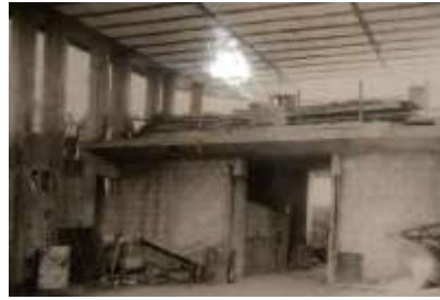
Costruzione del piano superiore
